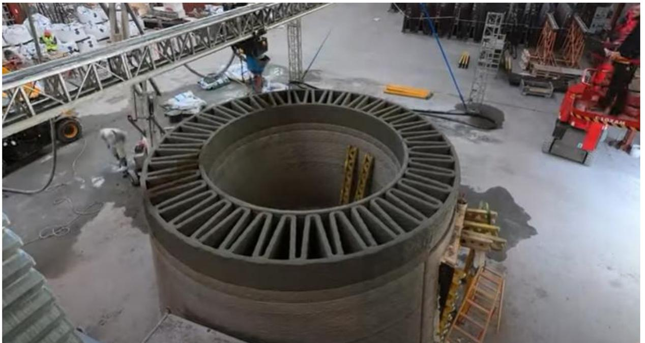
**Figura 48. Impresión de una torre de aerogenerador (COBOD, 2020).**
