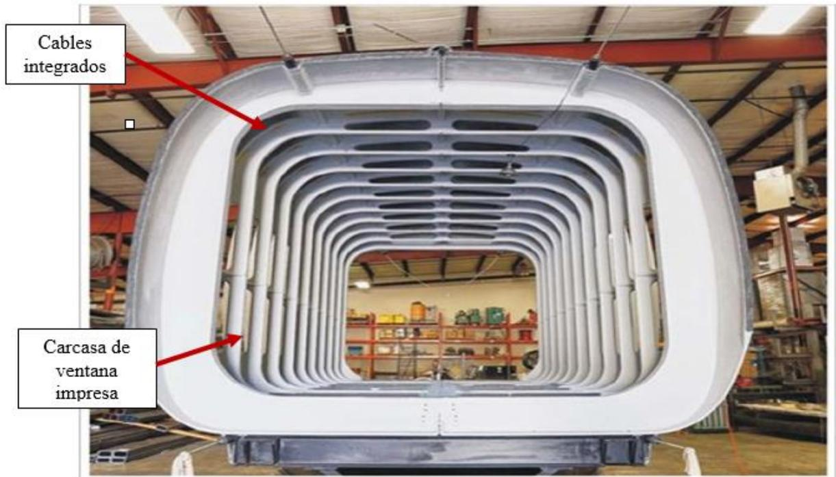
Figura 28. Estructuras funcionales en el proyecto AMIE (Malviya *et al.*, 2021).
