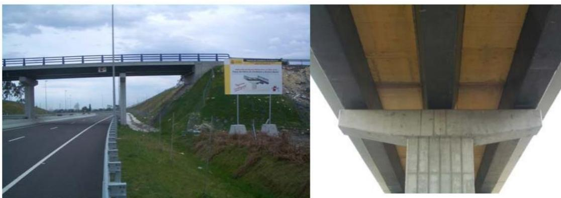
Figura 14 Primer puente de materiales compuestos construido en España (2004) [14]
